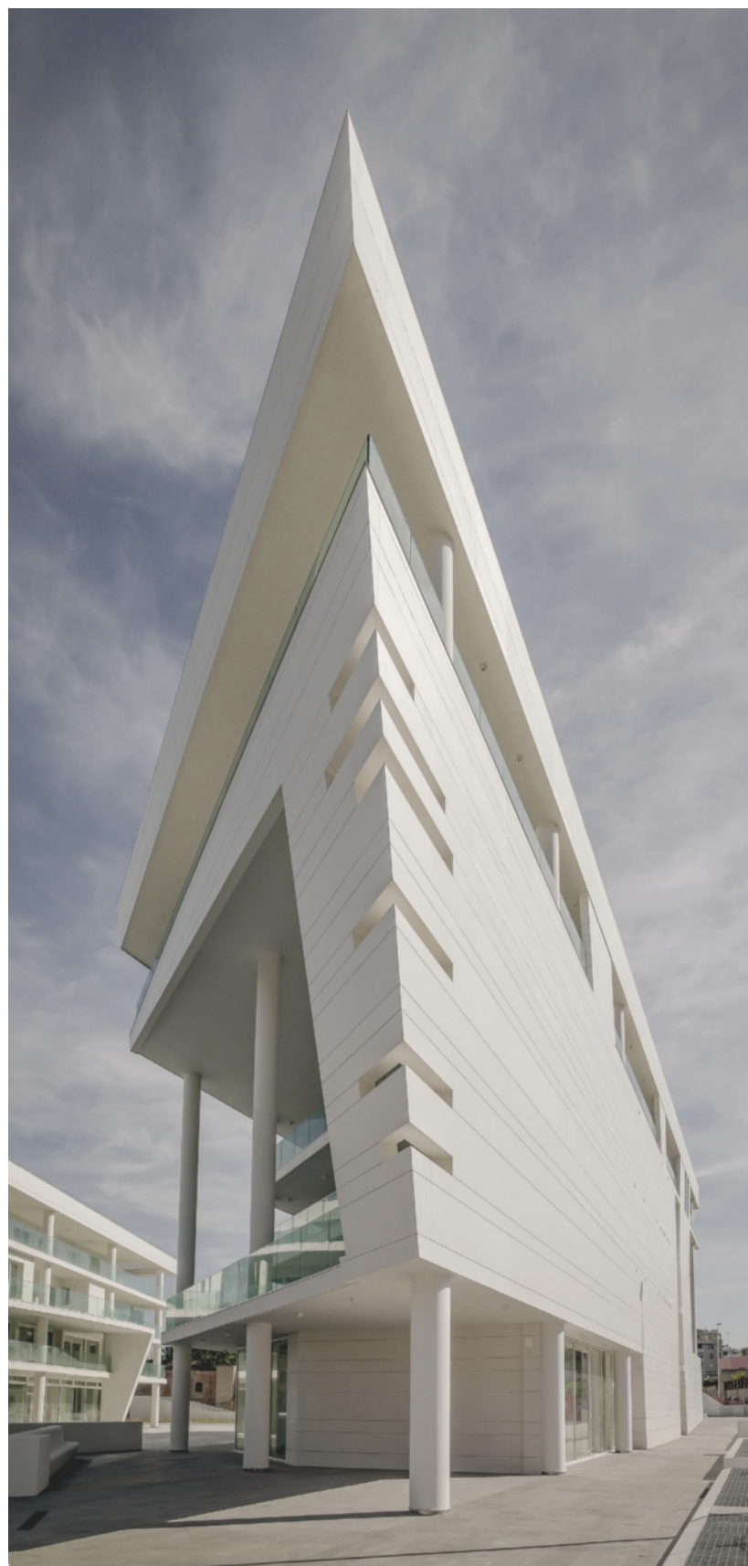
Edificio residenziale e commerciale, Cagliari/Italia, Design: Studio Fadda, Facciata Collection, Bianco Assoluto, Laminam 5 Various Sizes
